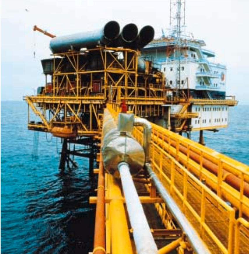
Vue de la plate-forme du champ de Yanga au Congo.
